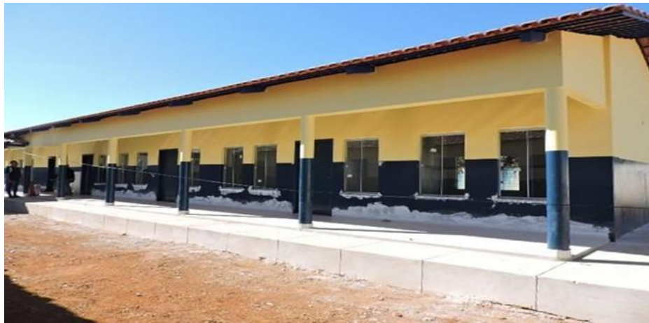
Figura 2 - Construção de novas salas da Esc. Mul. Tia Mirêta – Santa Rosa do Tocantins.
