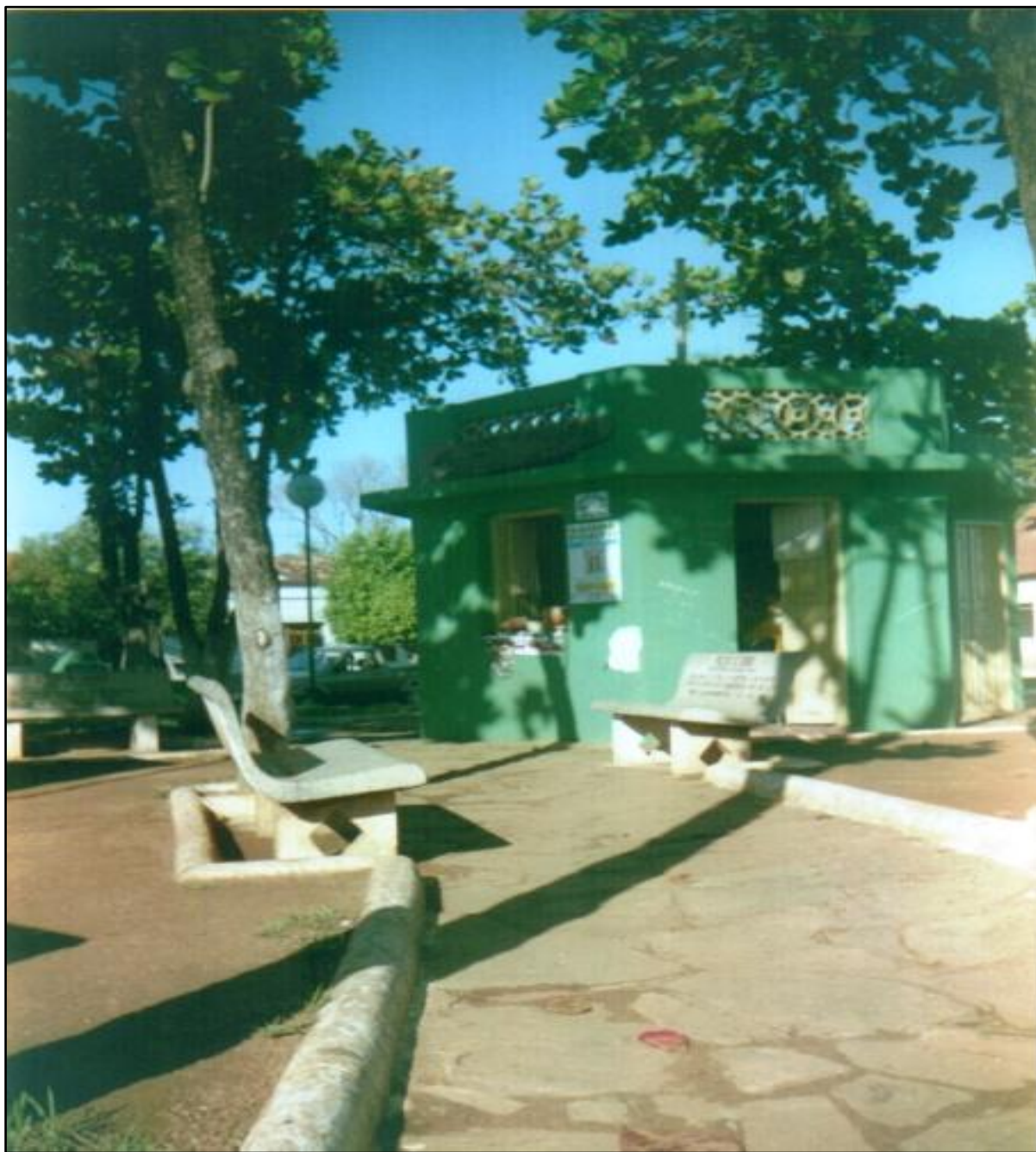
Figura 7. Antigo Coreto localizado na Praça Nossa Senhora das Mercês, em Porto Nacional-TO
