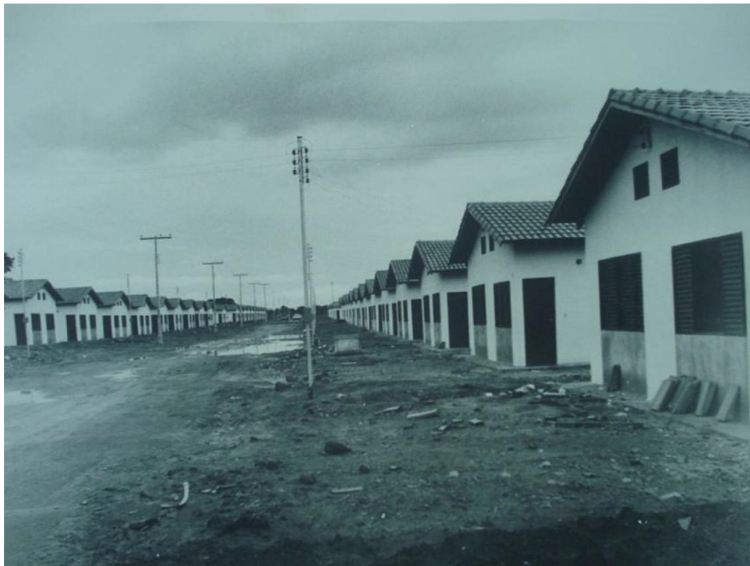
Figura 13 – Construções na ARSE 72 na Capital
