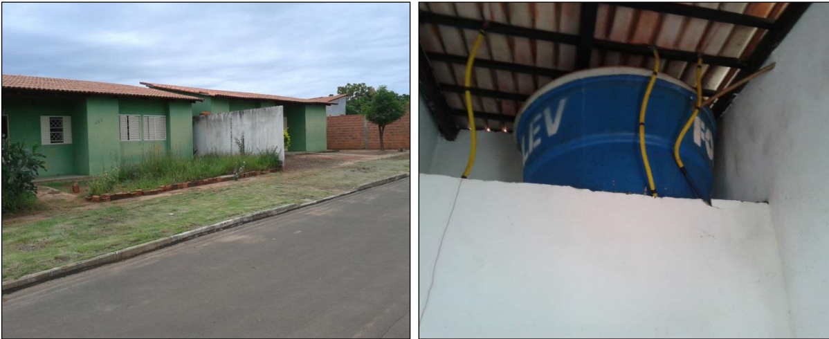
Imagens 3-4: Novas Condições de Moradia dos Ribeirinhos no “Reassentamento Novo Milênio”
