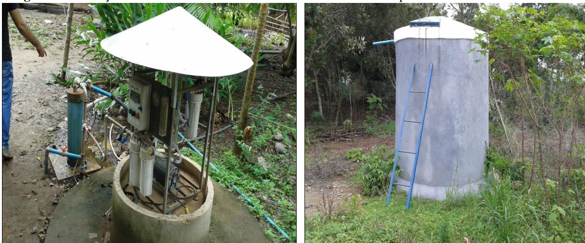
Imagens 12-13: Poço Artesiano e Sistema de Armazenamento Construídos pelo CESTE
