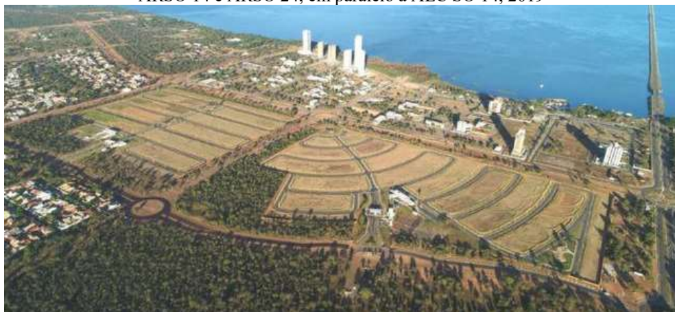
Figura 47 - Palmas: condomínio horizontal residencial fechado Alphaville Palmas 1 e 2, instalado nas quadras ARSO 14 e ARSO 24, em paralelo à ALC SO 14, 2019
