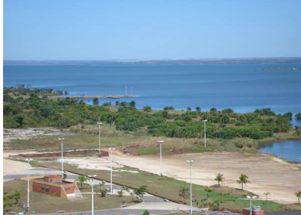
43a -Vista no sentido sudoeste
