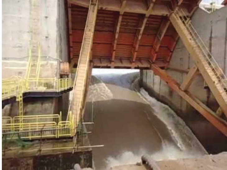
Figura 19 – Vertedouro tipo comporta
