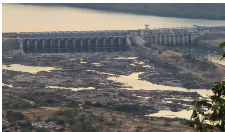
Figura 26 – Pedral à jusante dos vertedouros da UHE LEM
