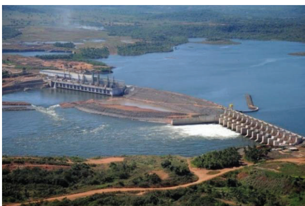
Figura 24 - Aproveitamento Hidrelétrico de Estreito
