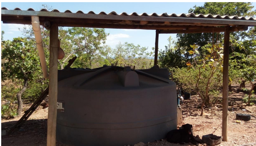
Figura 10 - Cisterna com cobertura para captação de água em Combinado
