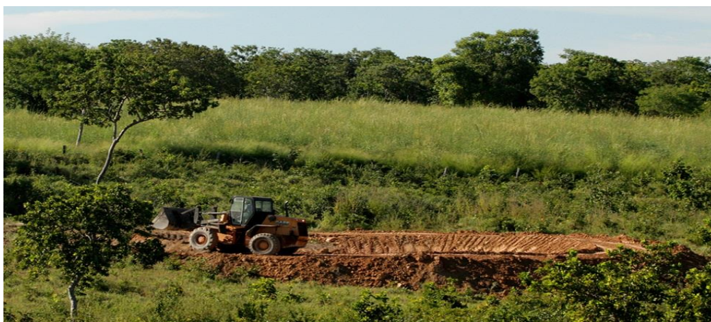
Figura 9 – Máquina construindo barragem e Novo Alegre – TO
