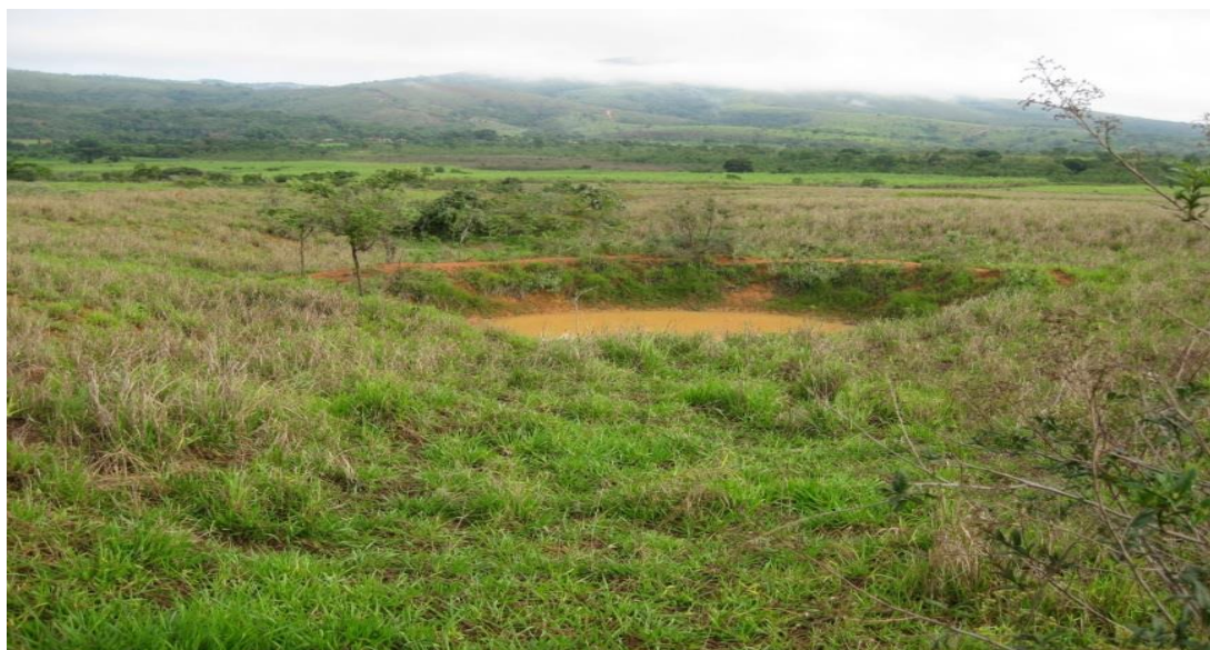
Figura 1 - Barraginha para controle de voçoroca
