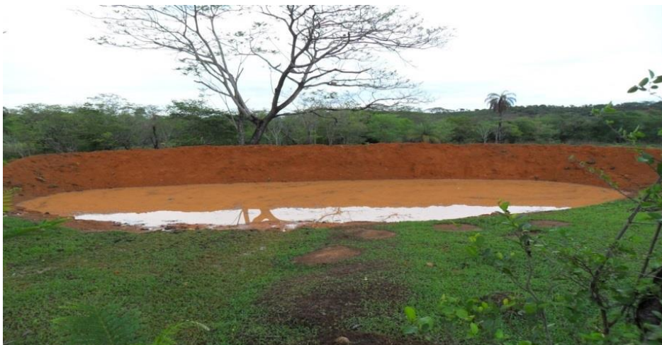
Figura 5 - Barraginha em construção município de Novo Alegre –TO.
