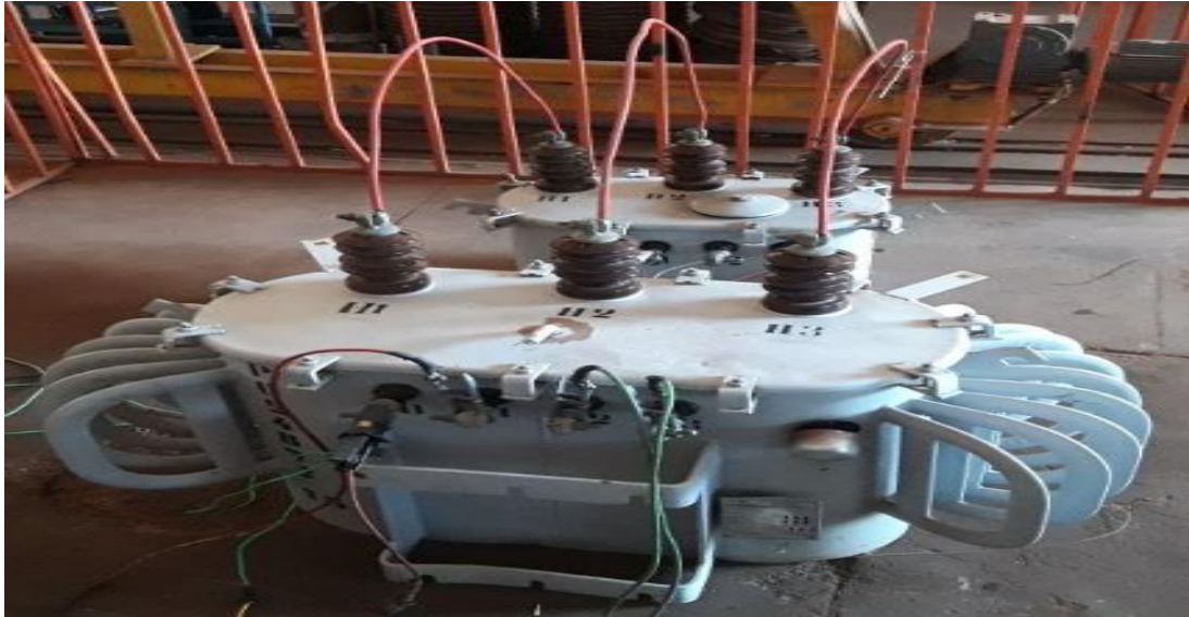
Figura 27 – Energização do trafo com OVI
