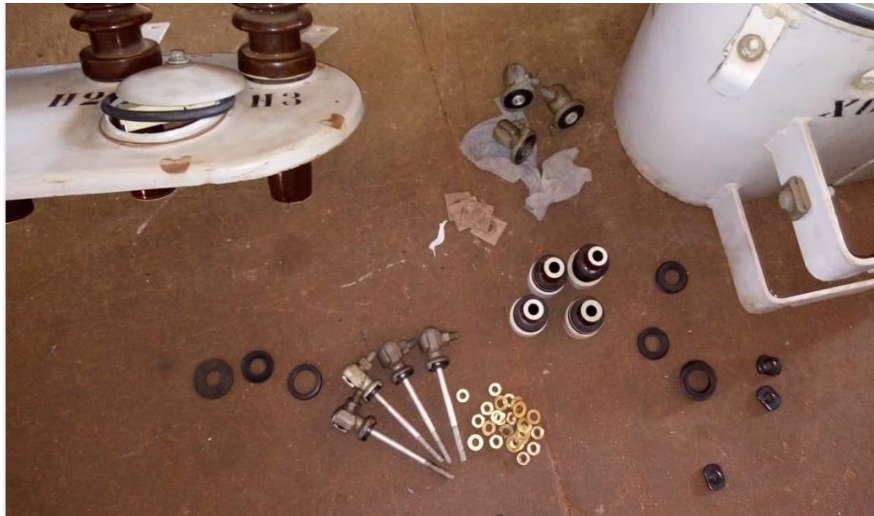
Figura 23 - Início da remontagem e conexão das buchas de AT e BT
