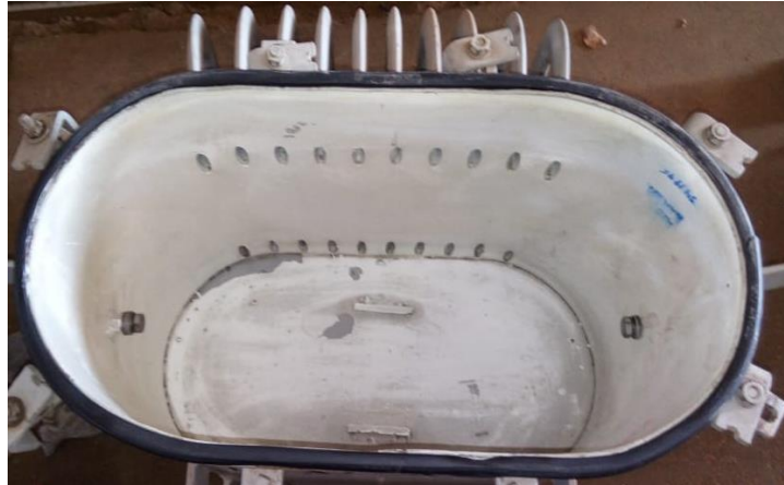
Figura 22 - Substituição da borracha nitrílica da tampa superior do trafo
