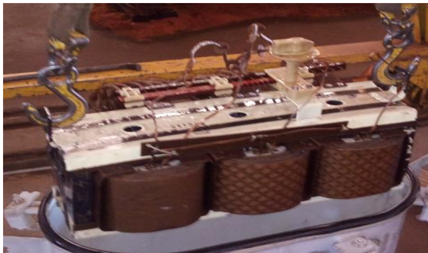
Figura 19 – Içamento do núcleo impregnado com OMI
