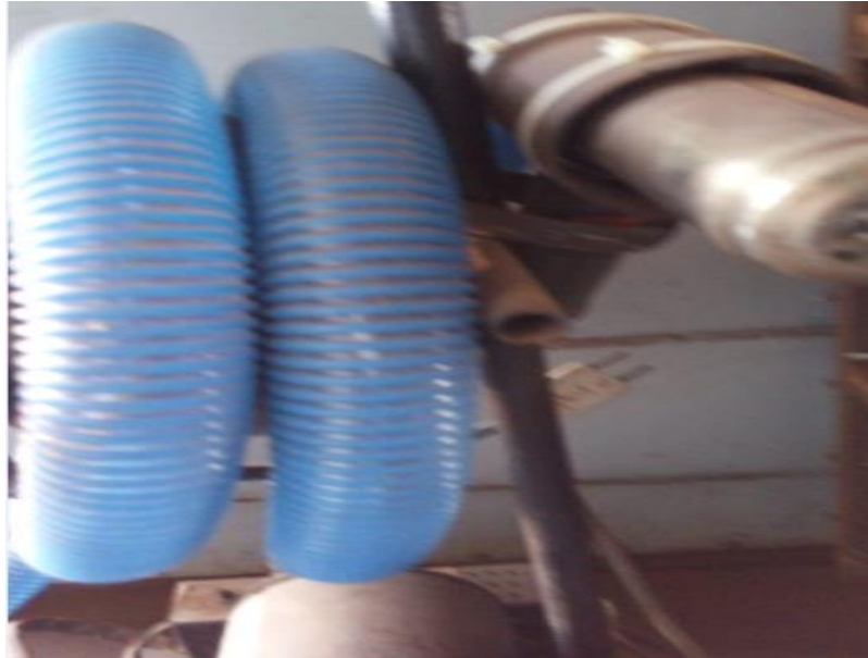
Figura 20 – Secador utilizado para secagem do vaso no trafo com OMI
