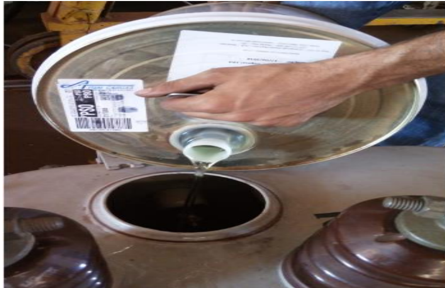
Figura 24 – Enchimento do trafo com OVI
