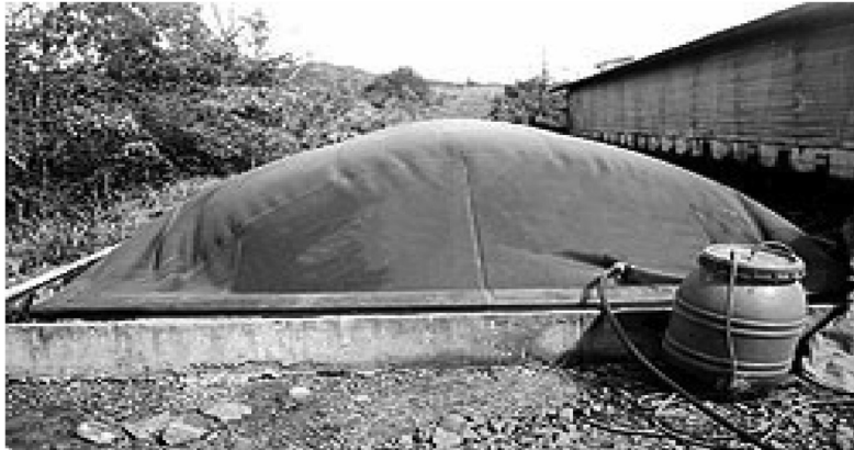
Figura 7 - Biodigestor com lona para confinar biogás
