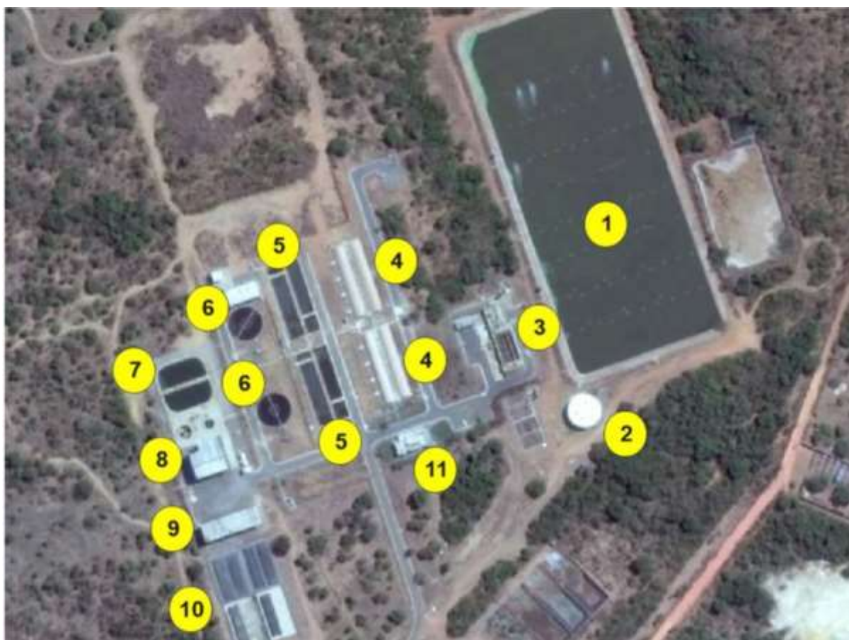
Figura 13: Imagem Satélite da ETE Norte
