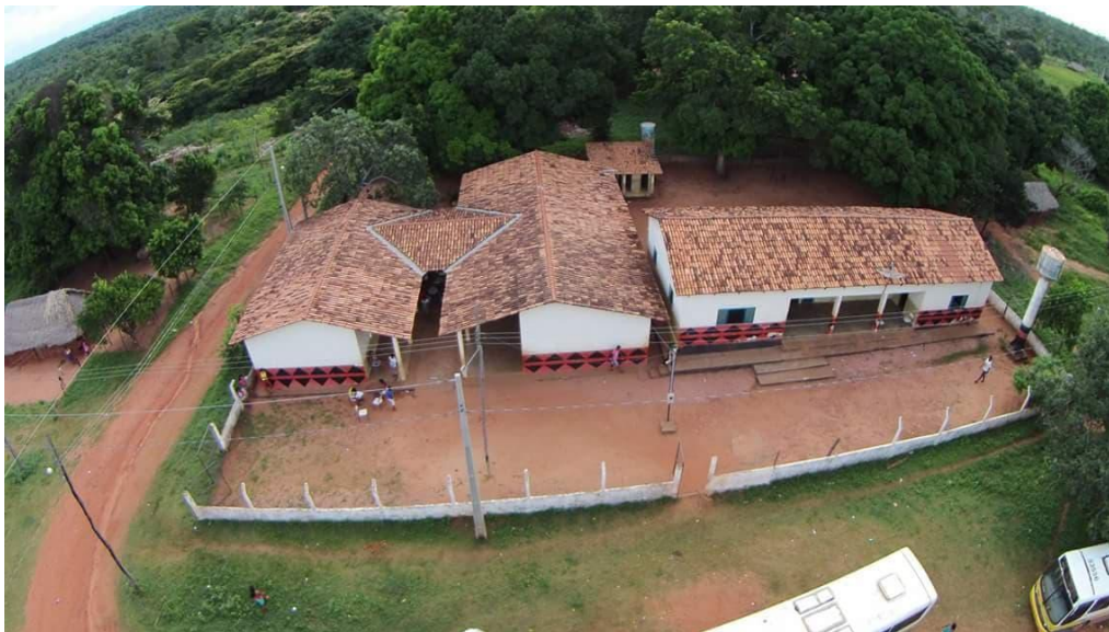
Figura 01 - Imagem aérea da Escola.
