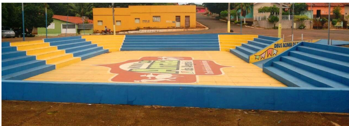
Figura 02 - Nova estrutura do quadrilhódromo
