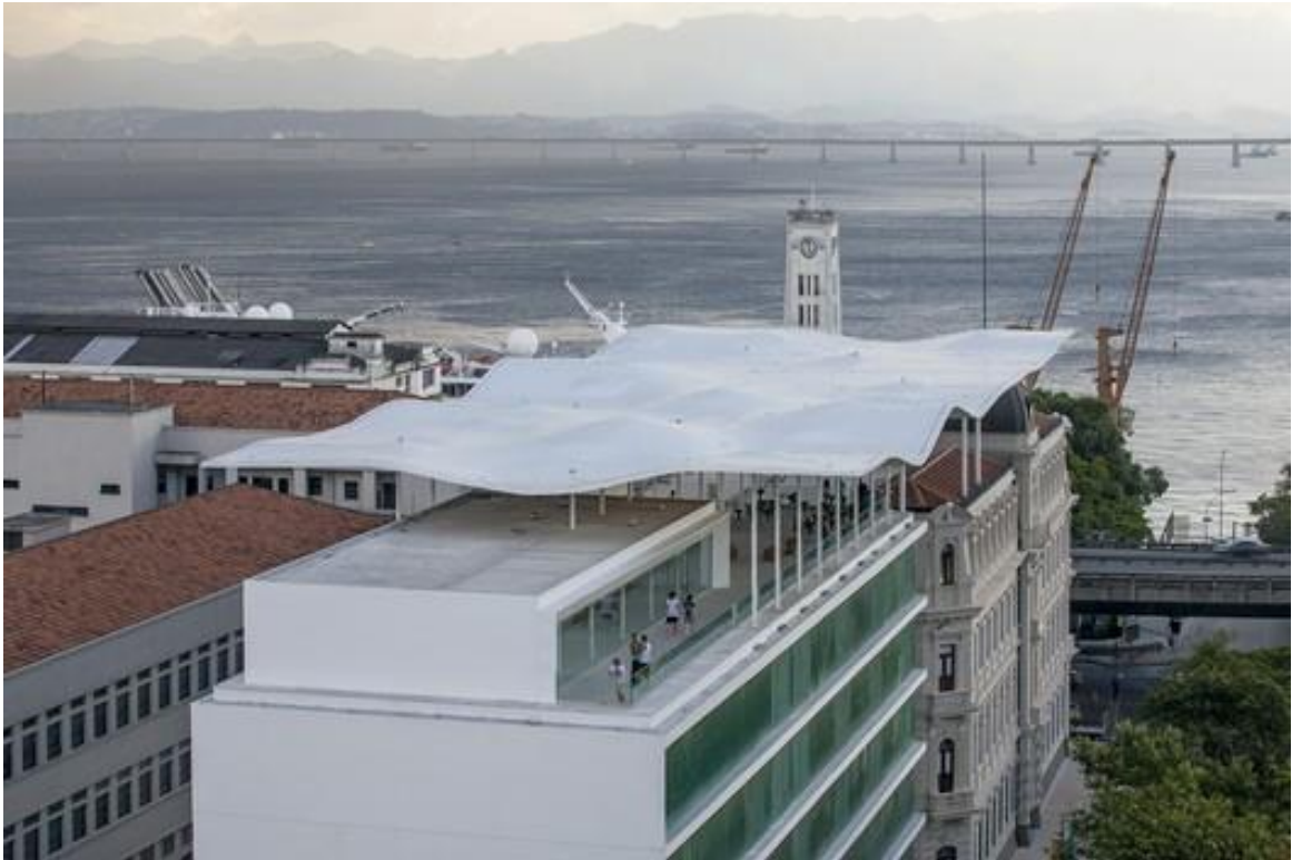
Figura 27 – Vista aérea - MAR
