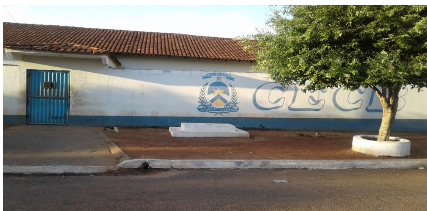
Imagem 1: Fotografia da parte frontal do Colégio Estadual Conceição Brito Fonte: Acervo fotográfico da UE.
