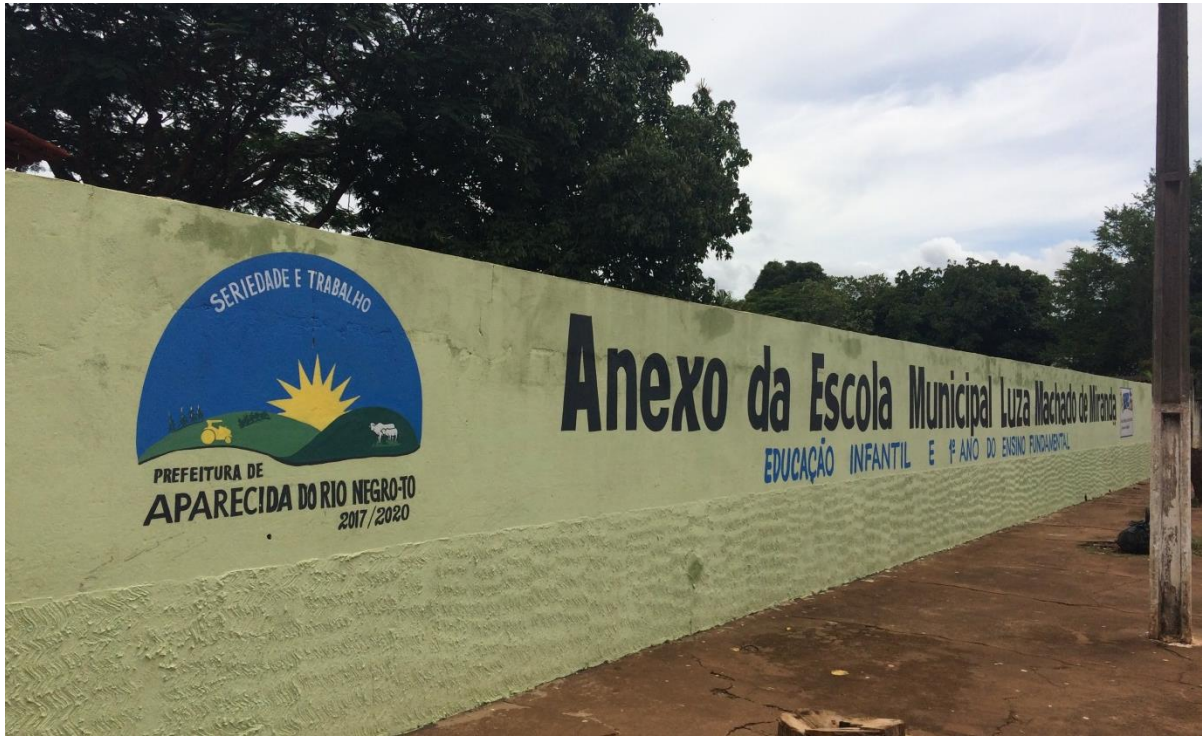
Figura 14 – Anexo da Escola Municipal Luiza Machado de Miranda-Aparecida do Rio Negro
