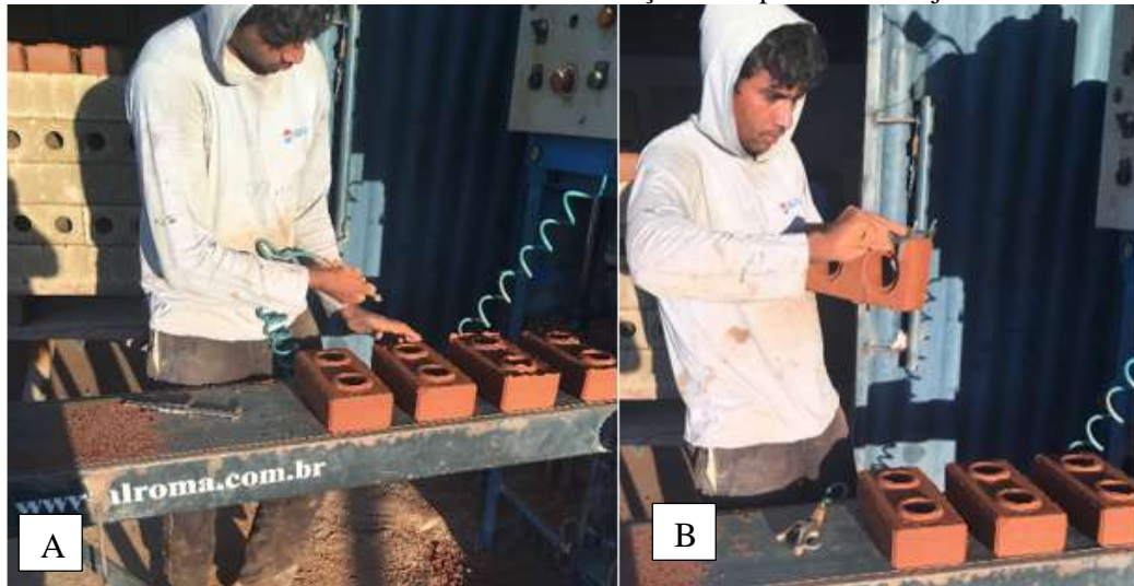
Figura 38- Finalização dos tijolos. A-Limpeza dos tijolos com ar comprimido. B- Medição da espessura dos tijolos.
