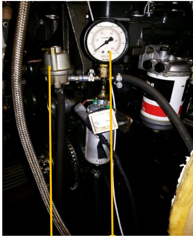
Bomba acoplada ao Manômetro
