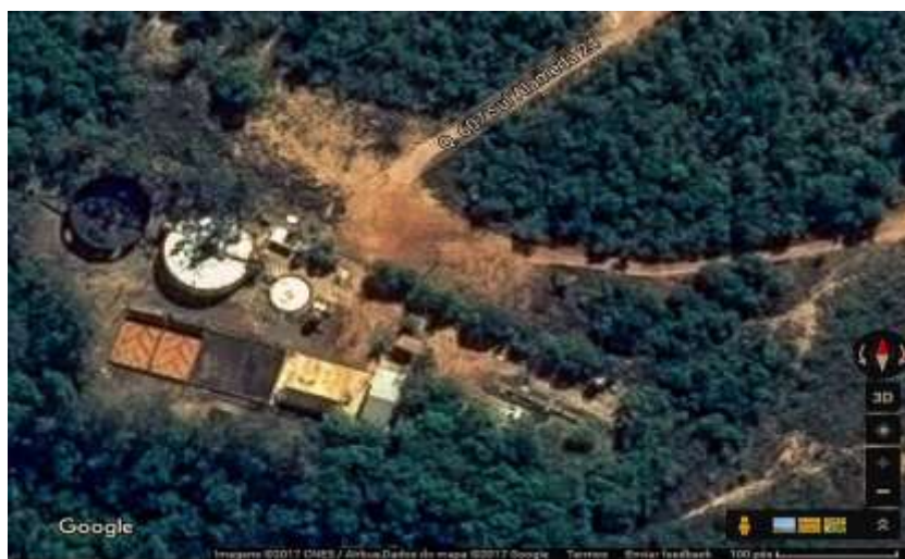
Figura 5. Vista aérea da ETE Prata
