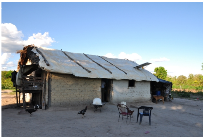
Foto 1 - Típica moradia na Comunidade dos Prazeres, com placa solar instalada pelo Programa Luz para Todos.
