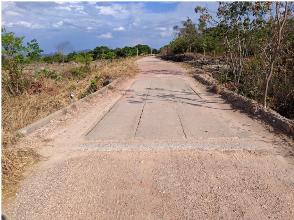
Fotografia 1 - Ponte de laje de cimento na estrada de acesso ao Território do Mimoso
