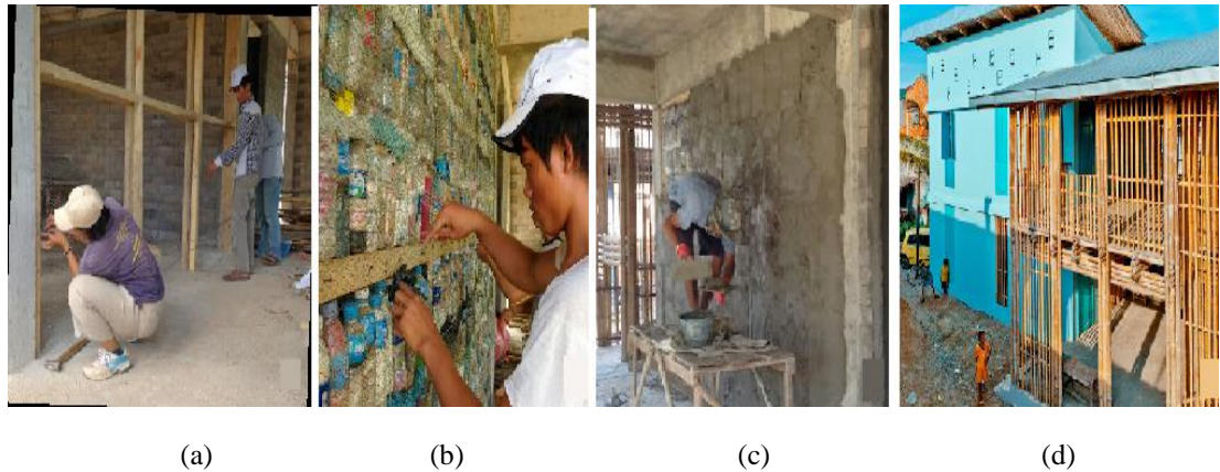
Figura 13 - Garrafas PET na vertical utilizadas na construção de paredes do Kouk Khleang Youth Center
