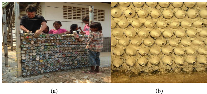
Figura 14- – Garrafas PET na horizontal utilizadas na construção de paredes da “Bottle School”
