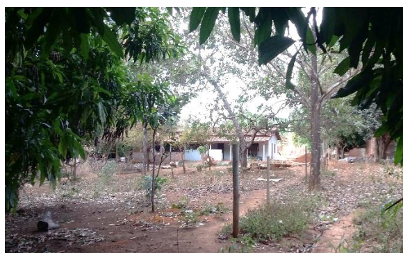
Figura 32 - Ocupação Irregular na AVU Parque Linear Urbano Água Fria - Setor Lago Norte (794230; 8876463)
