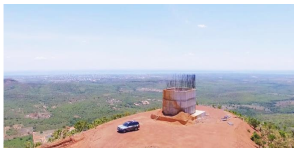
Figura 14 - Estrutura da base do monumento, instalada no ponto mais elevado da BHRAF (801982; 8872694)
