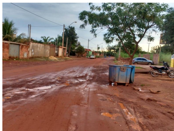
Figura 16 - Falta de infraestrutura - Setor Lago Norte (795044; 8875994)
