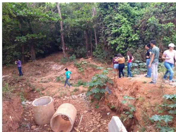
Figura 26 - Erosão do curso d'água Córrego Cachimbo - AVU Parque Linear Urbano Água Fria (794209; 8876416)
