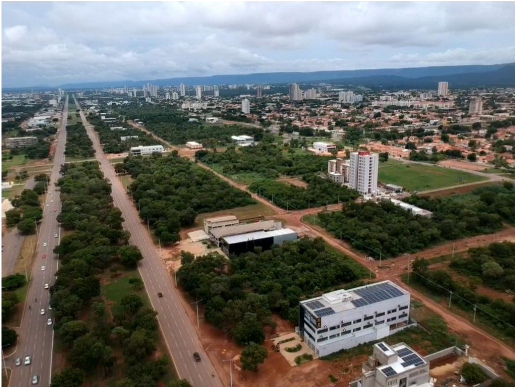
Figura 32. Foto aérea destacando apenas dois edifícios verticais em um amplo campo de visão.
