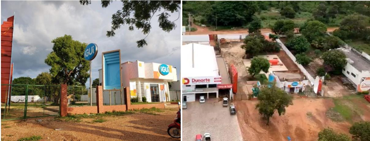
Figura 34 - Lote subutilizado por ter área construída insuficiente
