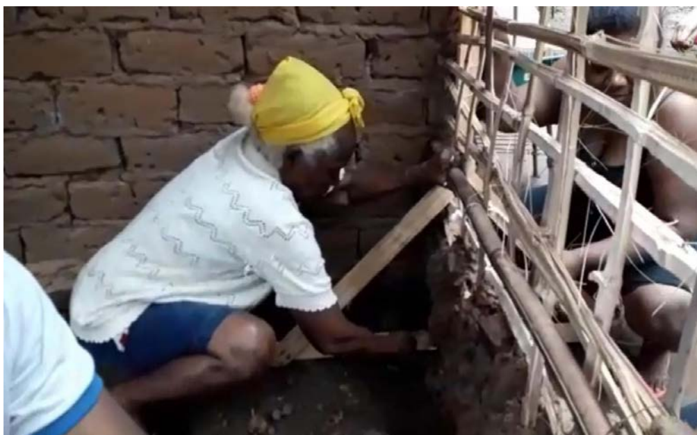
Figura 3 - Uma das mais antigas moradoras da Comunidade Barra da Aroeira fazendo a parede de taipa. 28
