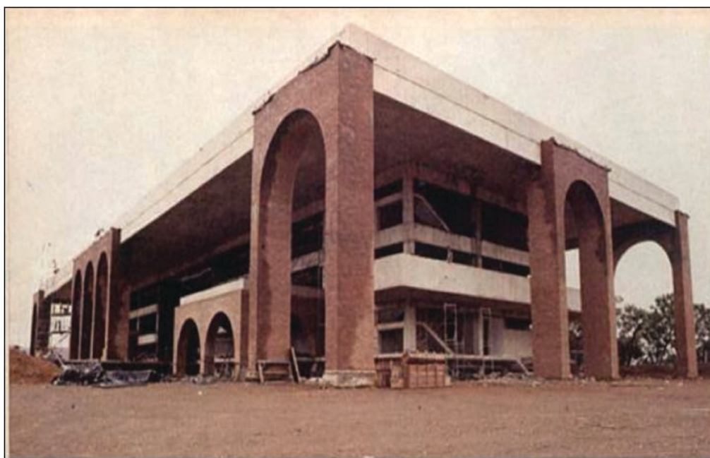
Figura 7 – Palácio sede do executivo em construção; os revestimentos cerâmicos cobrem todos os edifícios institucionais proporcionando sentimento de identidade e simbolismo no novo estado
