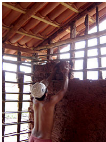
Fotografia 6 – Estirpe da palmeira babaçu servindo para estrutura de casa de taipa
