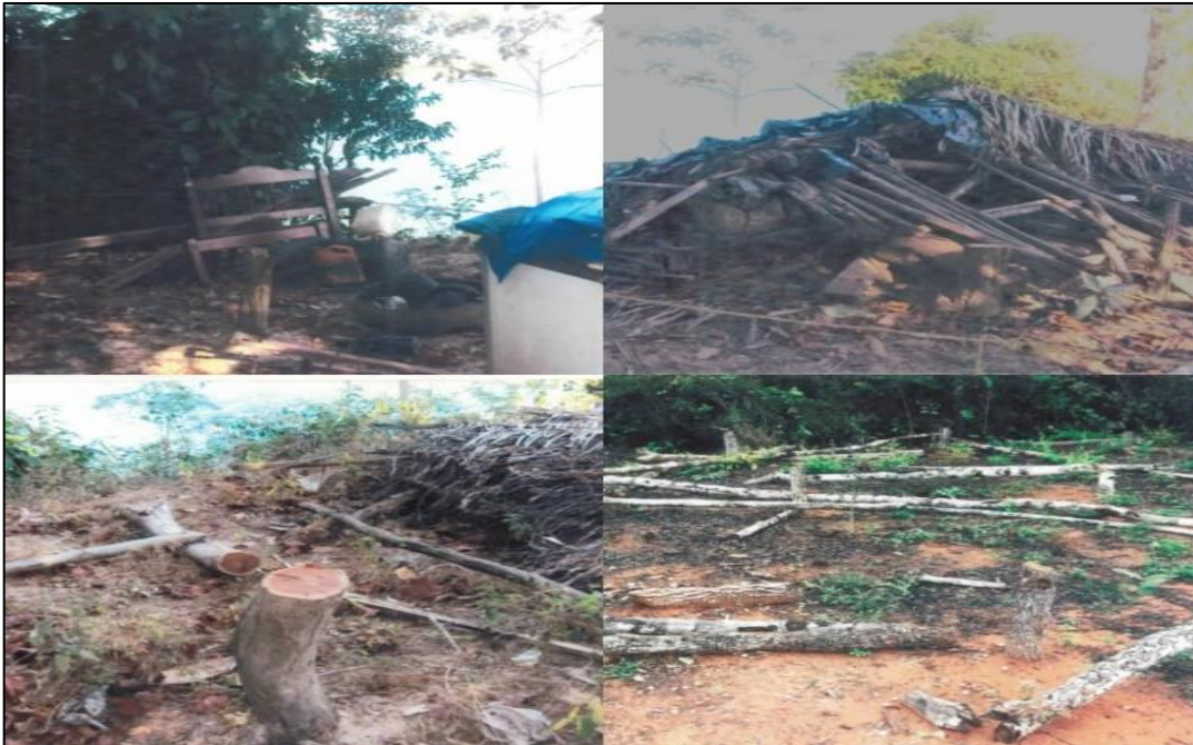
Fotografia 5 – Derrubada dos barracões do antigo território
