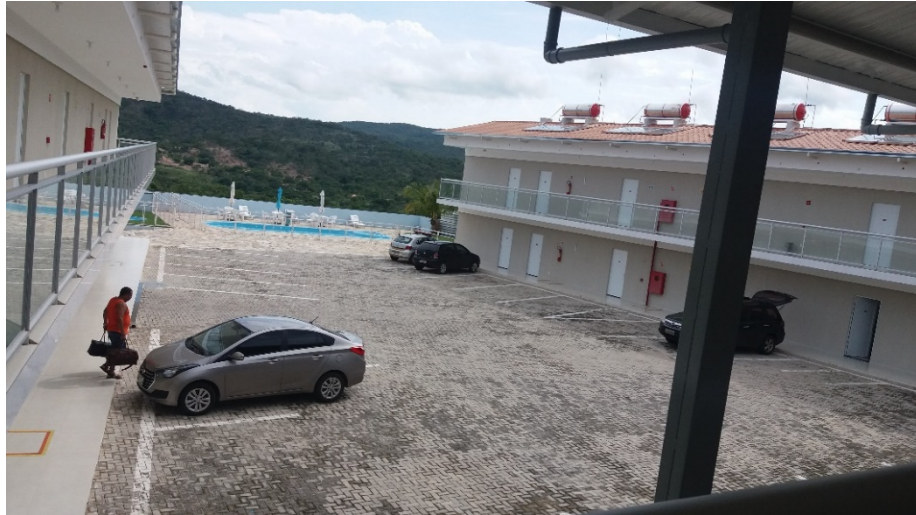
Figura 27: Garagem no Hotel Japão
