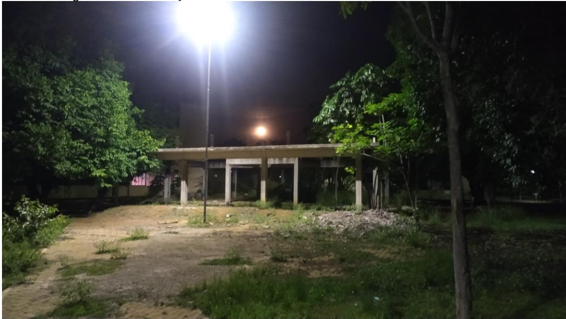
Figura 65 - Construção inacabada do centro de convivência – UFT Palmas.
