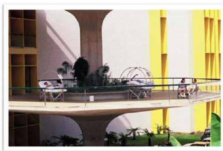
Figura 67 - Solário do Hospital Sarah de Belo Horizonte/MG.
