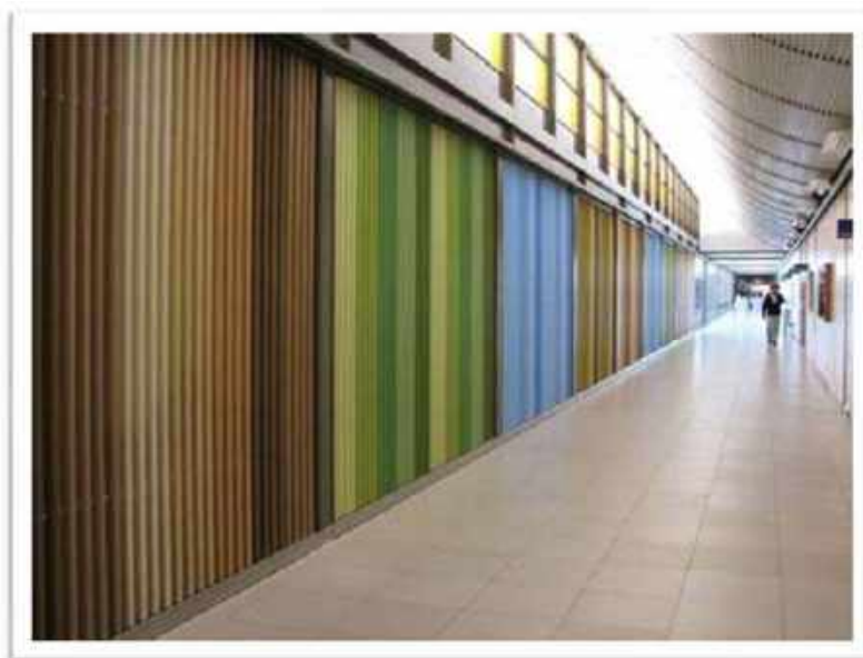
Figura 79 - A divisória em lâmina de madeira colorida entre a fisioterapia e a circulação do Hospital Sarah Lago Norte/DF.
