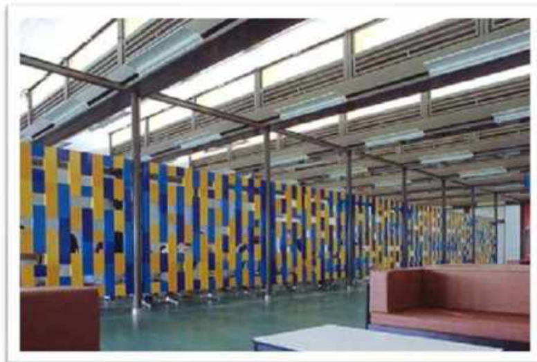
Figura 78 - Treliza de ferro utilizada como divisória no Sarah de Salvador.
