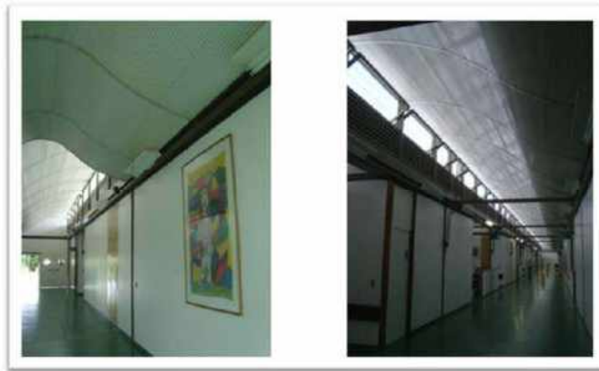
Figura 94 – Iluminação natural - Sheds
