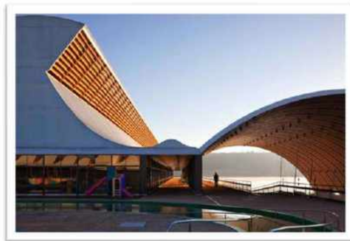
Figura 27 - Ventilação Natural a partir dos "sheds" do Hospital Sarah Kubitschek, Salvador - BA, João Filgueiras Lima (Lelé)
