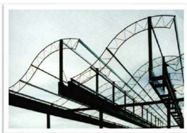
Figura 92 - Montagem da cobertura (Sheds) de aço do Hospital Rede Sarah Kubitschek Salvador, Bahia.
