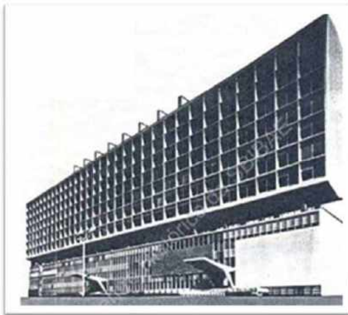
Figura 24 - Imagem do primeiro edifício construído do Complexo do Morumbi do Hospital Israelita Albert Einstein (HIAE).
