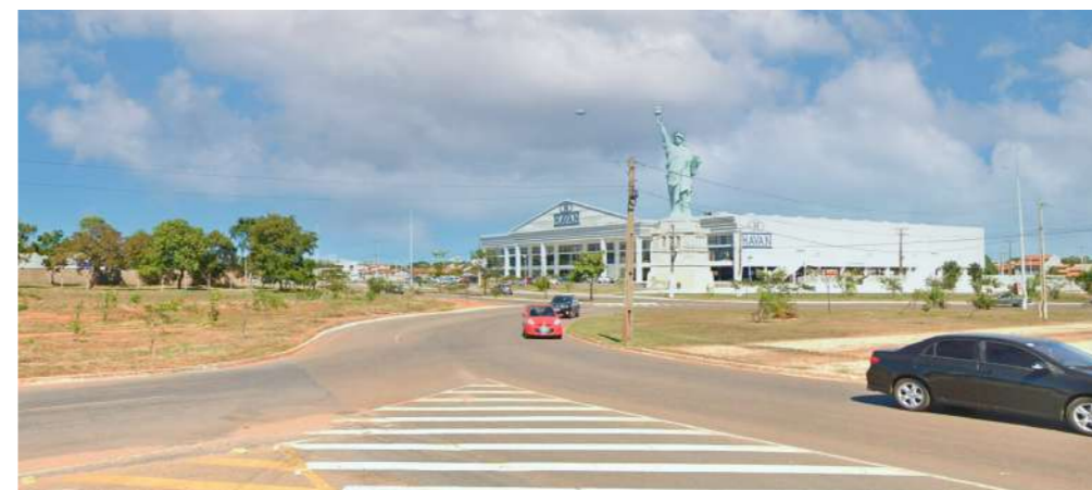
Figura 36: Vista da rotatória tangente ao terreno Fonte: Google Earth adaptado pelo autor.
