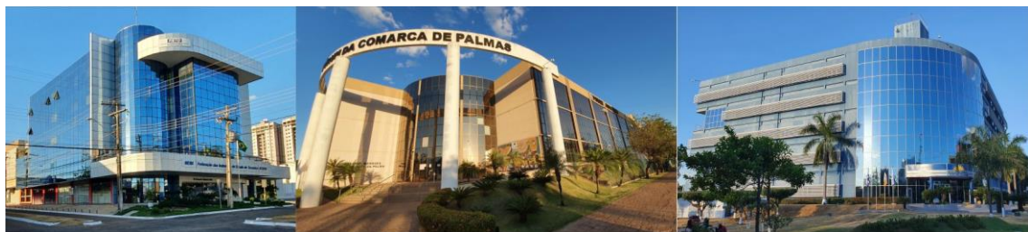
Figura 12 - Exemplos de Alguns Prédios Não Residenciais Com Peles de Vidros e Voltados Para Oeste em Palmas. Da Esquerda Para a Direita, Sede da Federação das Indústrias do Tocantins (Fieto), Fórum de Palmas e Ministério Público.
