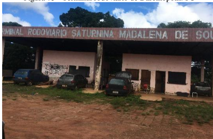
Figura 75 - Terminal rodoviário de Darcinópolis/TO
