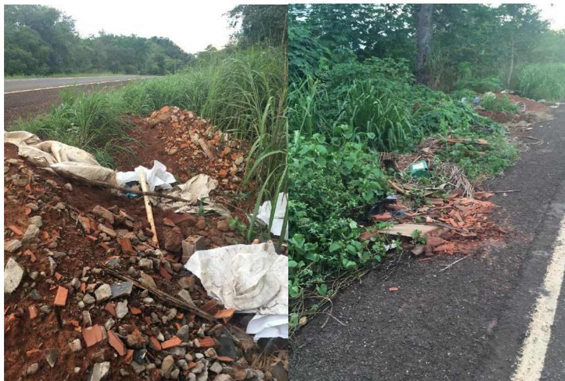
Figura 71 - Disposição inadequada nas margens da rodovia: TO-134
