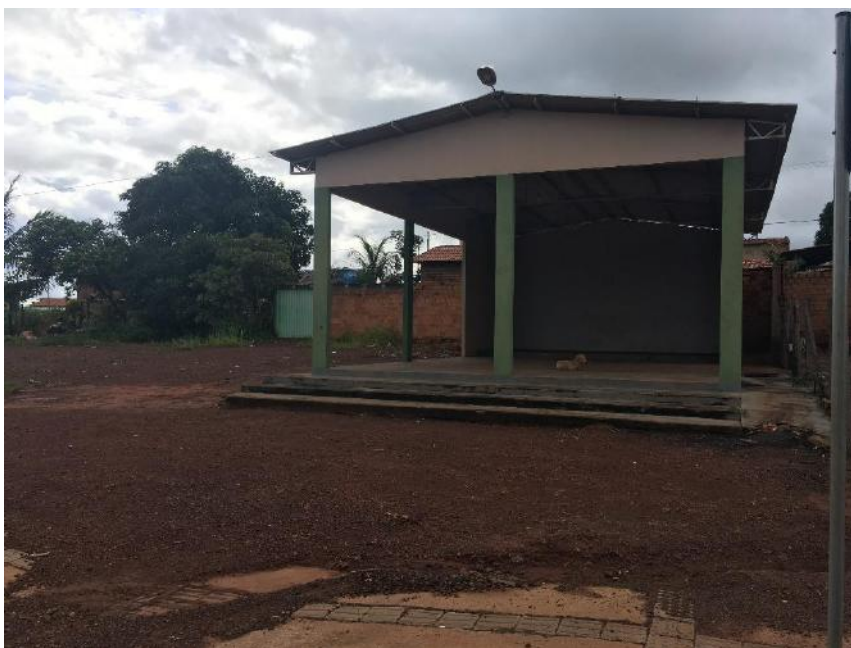
Figura 33 - Antiga área do lixão, coordenada geográfica Long.: 196692.96 m E e Lat.: 9258044.61 m S
