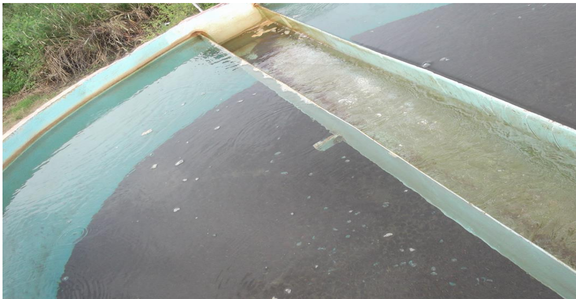
Figura 6. Vista do leito filtrante normal (2016).
