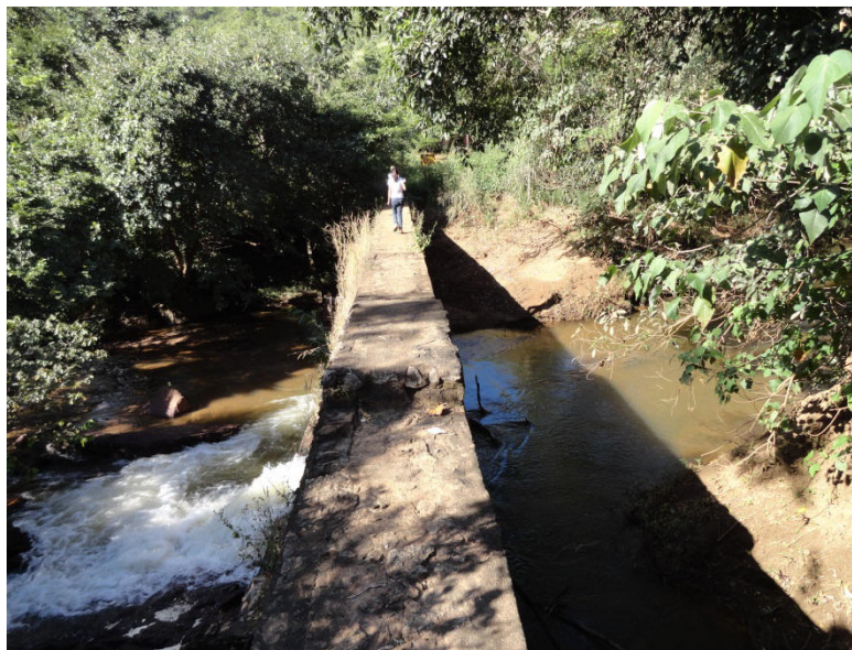
Figura 33. Vista da barragem de acumulação de água no ribeirão Taquaruçu Pequeno.
