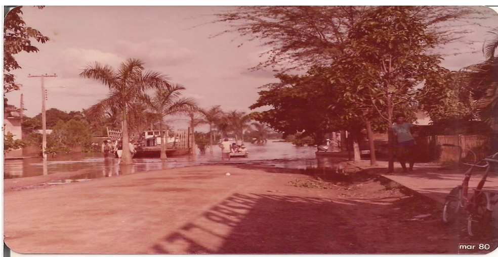
Imagem 15: Avenida Tocantins inundada pela enchente de 1980.
