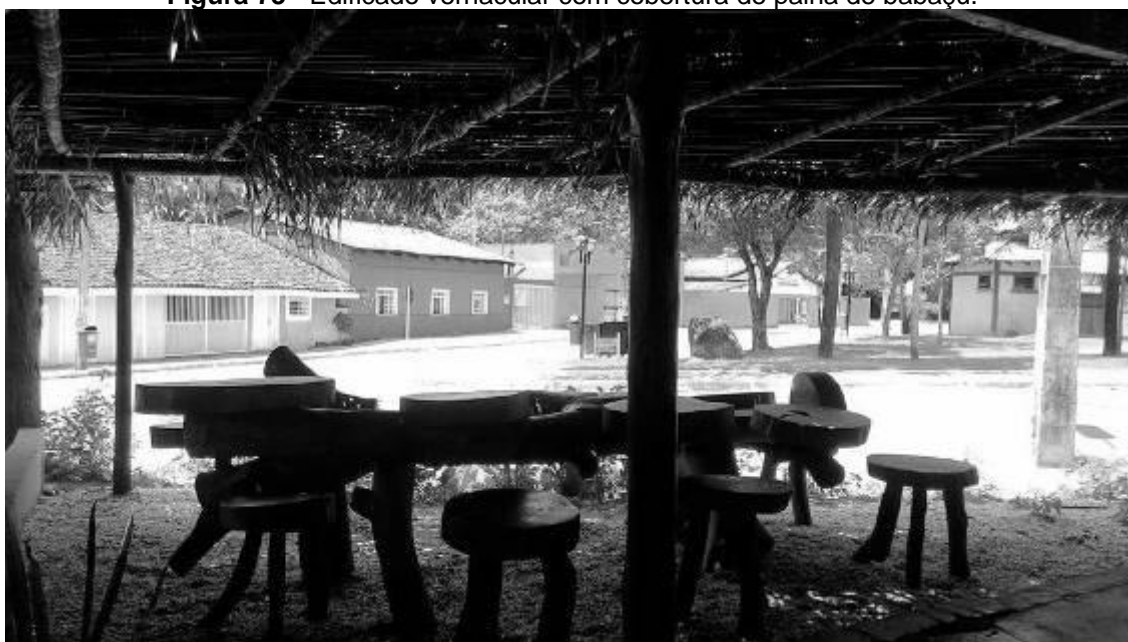
Figura 73 - Edifício vernacular com cobertura de palha de babaçu.
