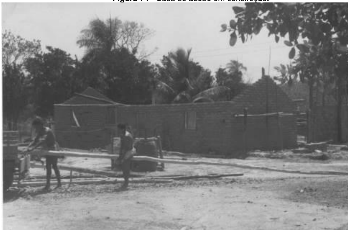
Figura 74 - Casa de adobe em construção.
