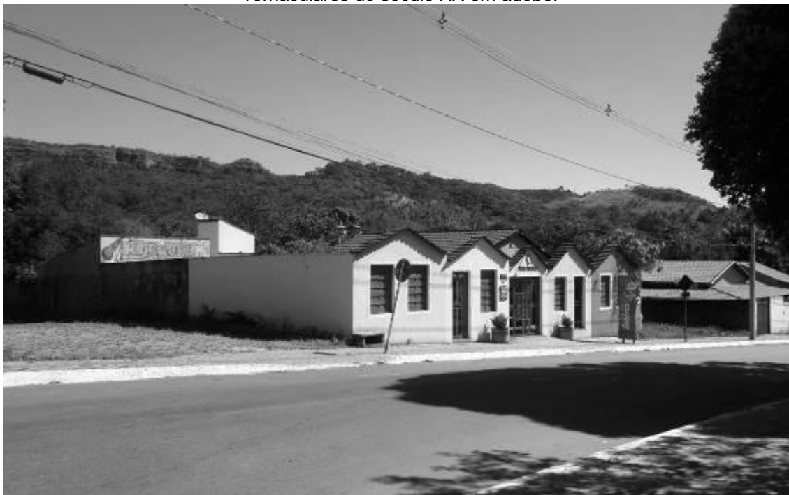
Figura 109 - Novas construções comerciais - alvenaria comum imitando as casas vernaculares do século XX em adobe.
