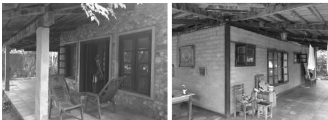
Figura 107 - Construção em adobe Tipo B do século XXI.
