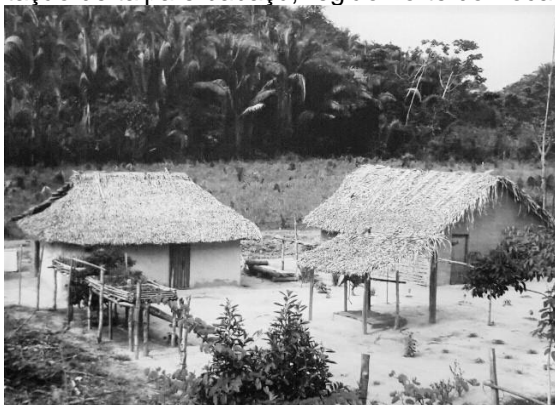
Figura 8 - Habitação de taipa e babaçu, região norte do Tocantins, Bico do Papagaio.
