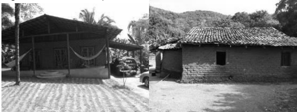
Figura 102 - Cobertura do Tipo B com telhado inferior anexado à construção principal.
