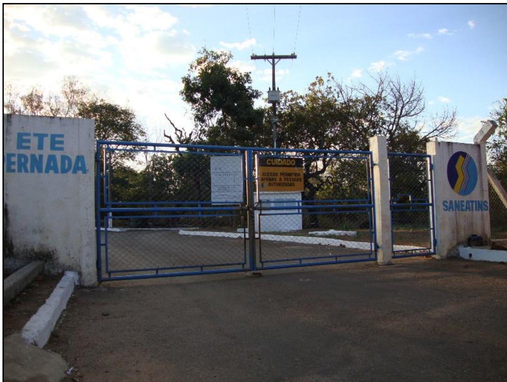
Figura 13 - Acesso à Estação de Tratamento de Esgoto de Paraíso.
