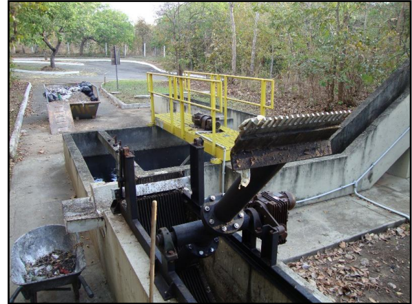
Figura 16 - Gradeamento Mecanizado.
