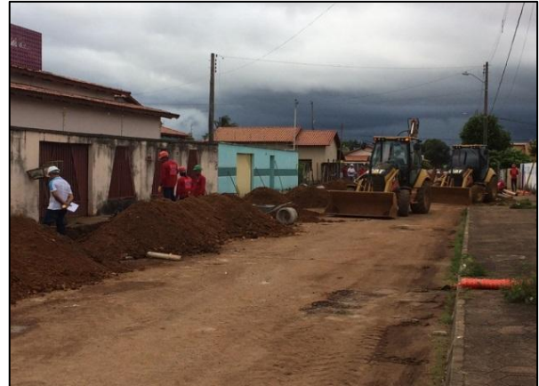
Figura 34 – Ampliação das redes coletoras.
