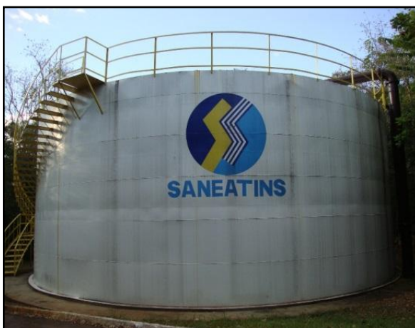
Figura 17 - Reator UASB
