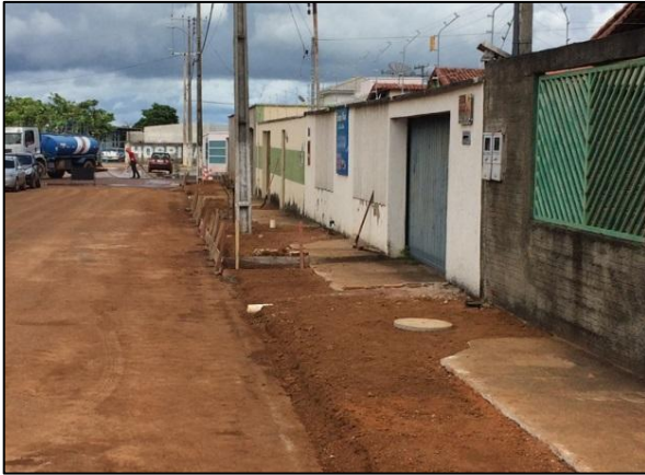
Figura 33 – Ligações de Esgoto realizadas.
