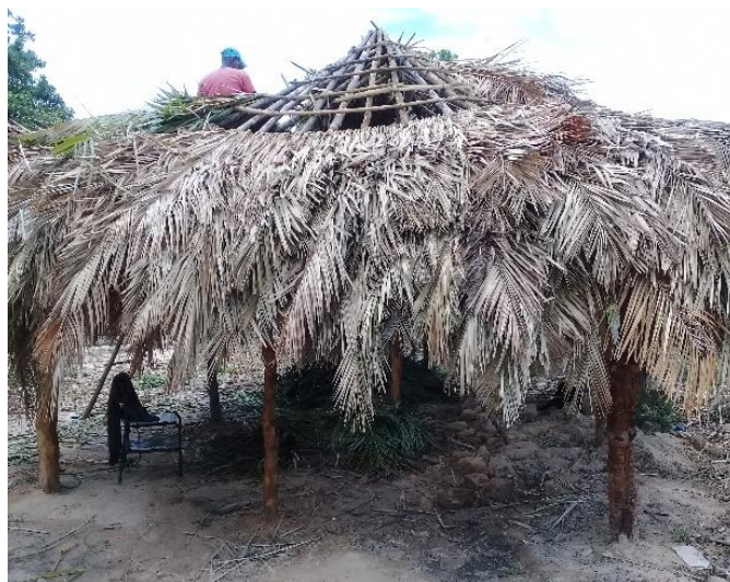
Figura 08: Construções de palha.
