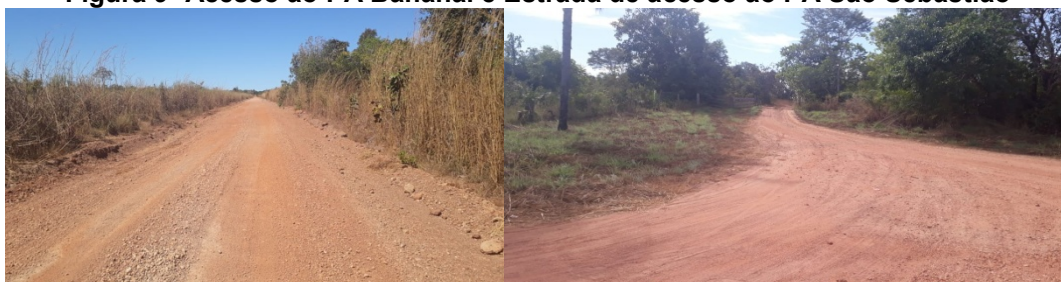
Figura 9- Acesso ao PA Bananal e Estrada de acesso ao PA São Sebastião
