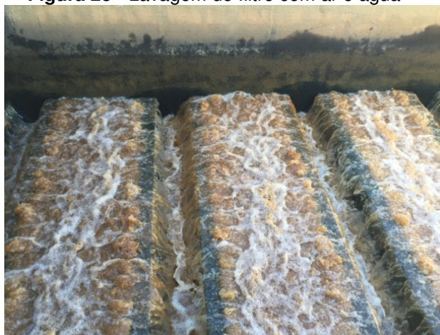
Figura 25 - Lavagem do filtro com ar e água
