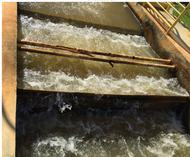
Figura 12 – Vertedor Retangular e aplicação da cal hidratada
