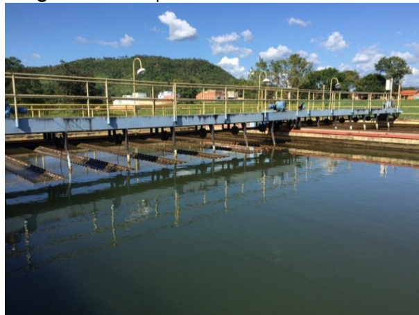
Figura 19 – Raspadores de lodo mecanizados
