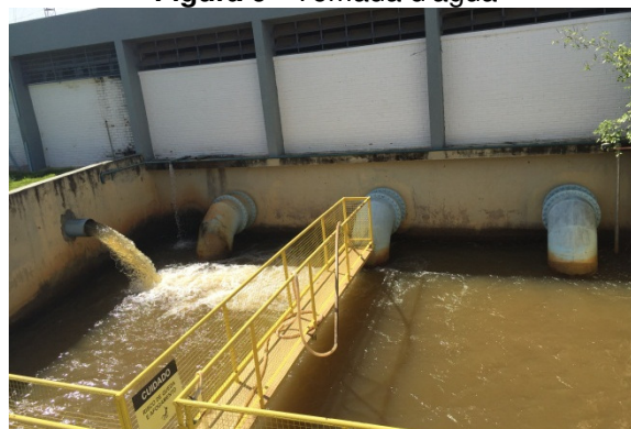
Figura 9 - Tomada d'água
