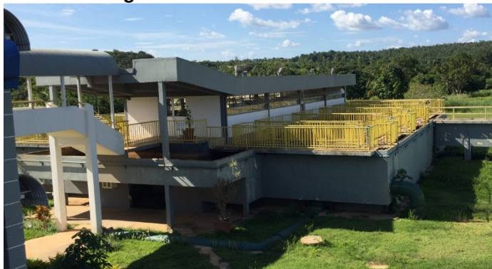
Figura 20 – Vista lateral dos filtros
