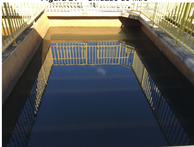
Figura 21 – Unidade de filtro
