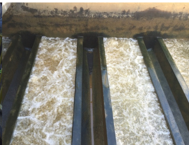
Figura 24 – Lavagem do filtro com ar
