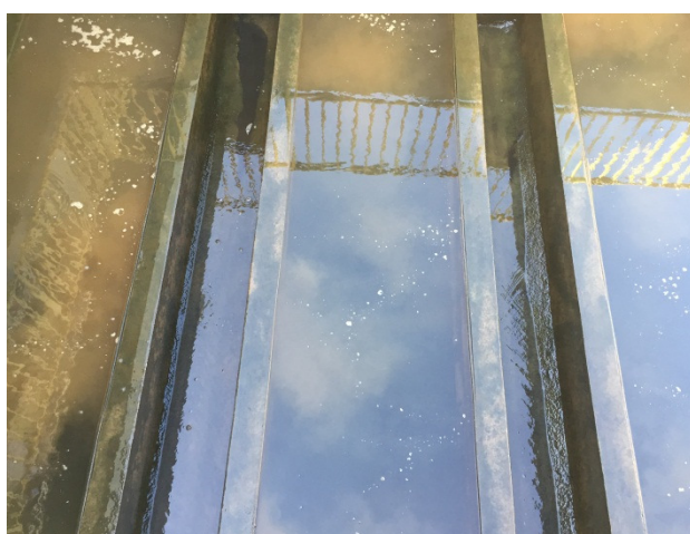
Figura 27 – Encerramento da lavagem do filtro
