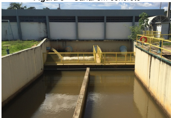
Figura 8 – Canal em concreto
