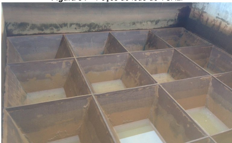
Figura 34 – Poços de lodo do TCALF
