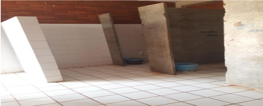
Fotografia 2: banheiros da escola estadual
