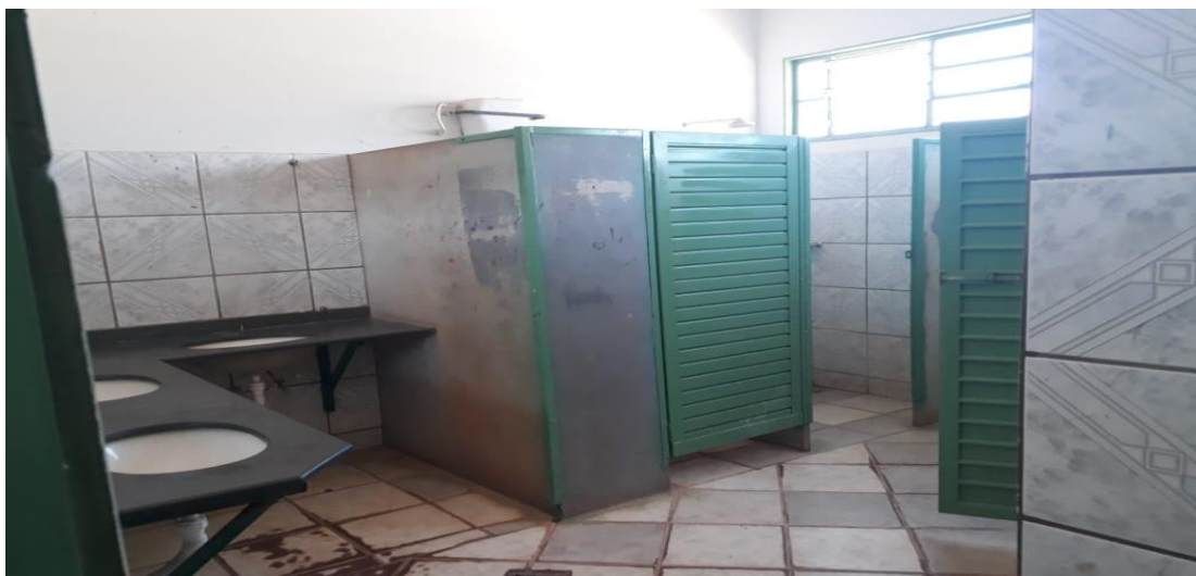
Fotografia 5: banheiro da escola municipal
