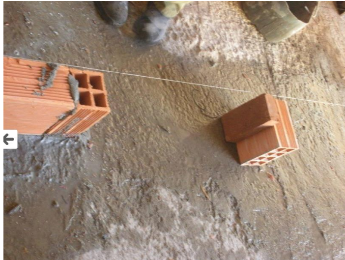
Figura 7 – Linha guia para assentamento
