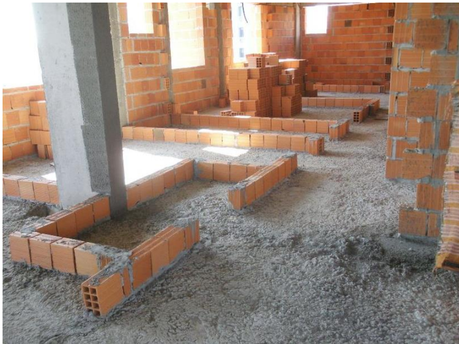
Figura 6 – Marcação e primeira fiada
