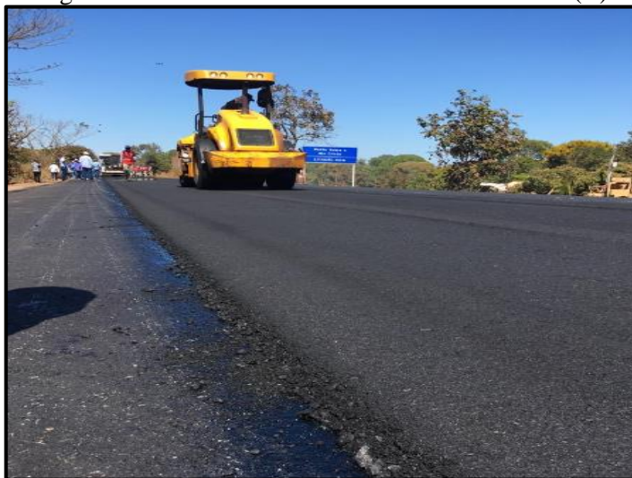
Figura 8 – Trecho executado com asfalto borracha (B)
