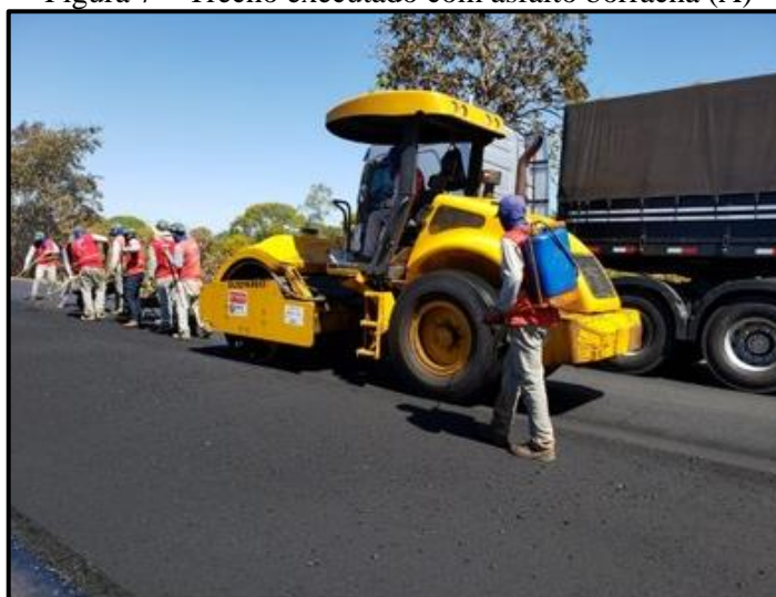
Figura 7 – Trecho executado com asfalto borracha (A)
