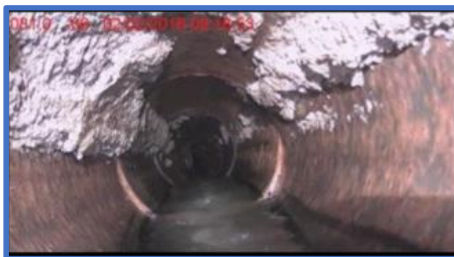
Figura 11 - Uso da câmera de inspeção
