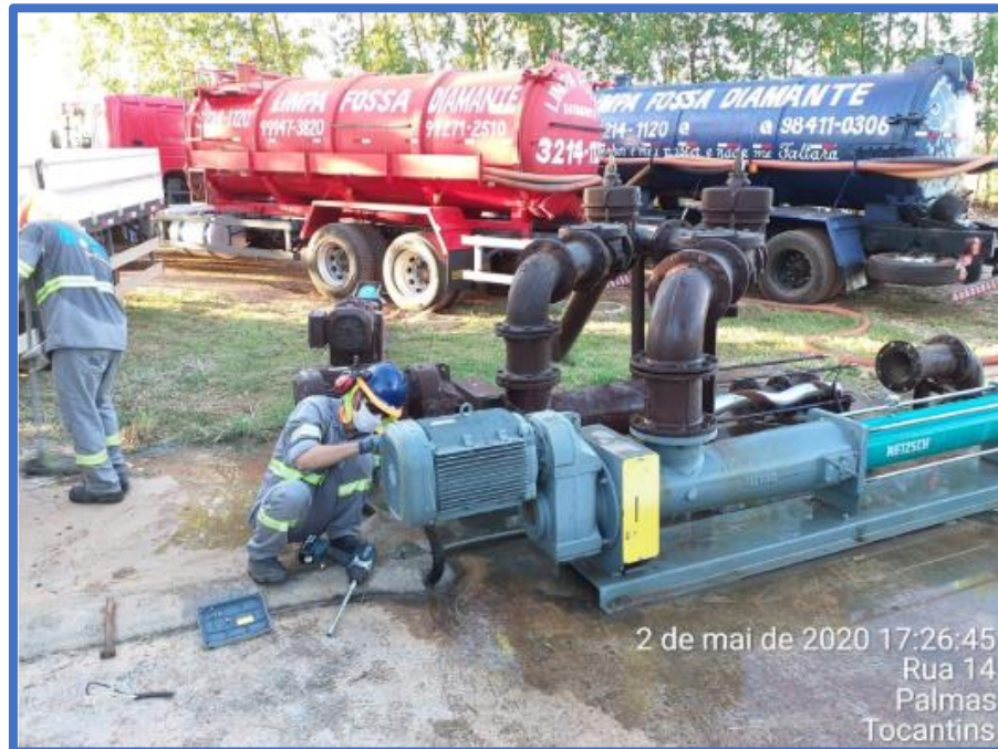
Figura 9 - Uso de limpa-fossa em atividade preventiva em uma estação elevatória de esgoto
