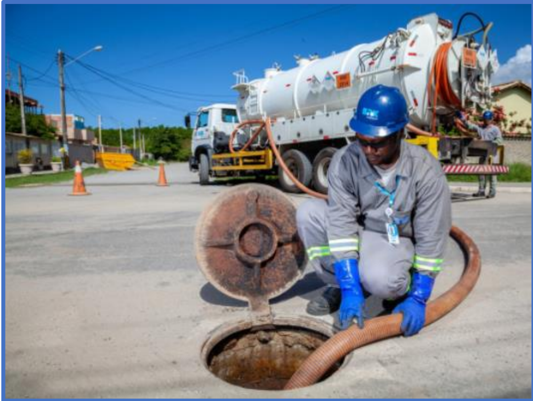
Figura 8 - Hidrojateamento em rede coletora de esgoto
