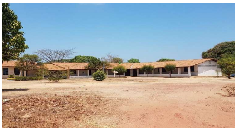
Imagem 1 – Área externa frontal da escola campo
