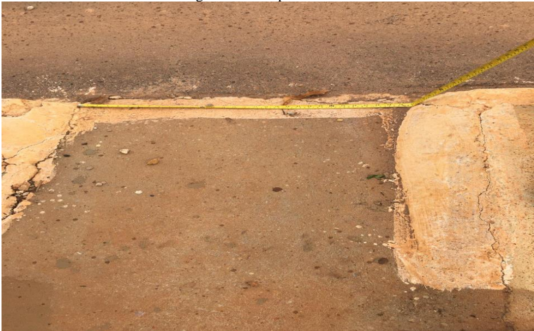
Figura 14- Rampa de acesso
