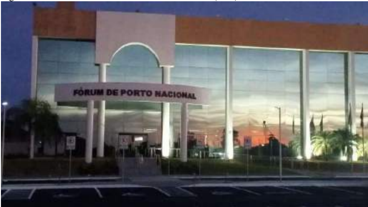
Figura 1 – Edifício do Fórum de Porto Nacional-TO (sede)
