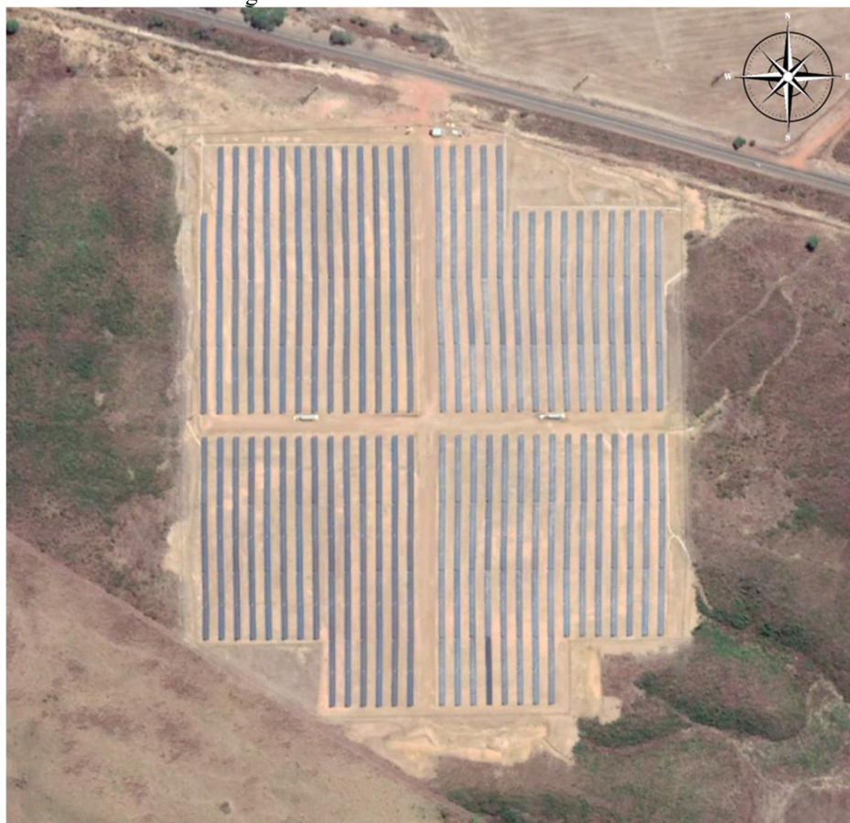
Figura 12 – Usina Fotovoltaica Miracema.
