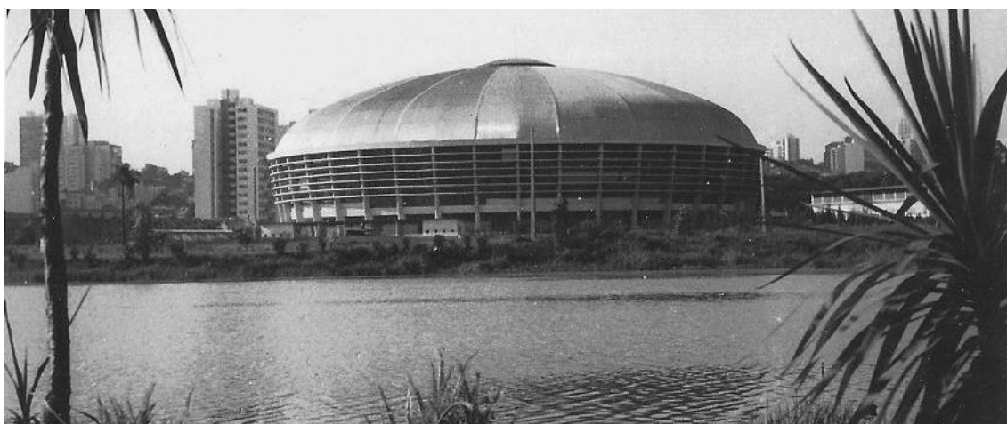
Figura 8 - Fachada do Ginásio
