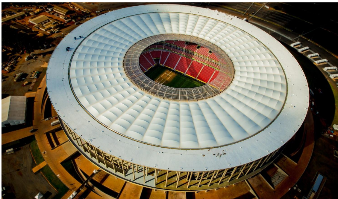
Figura 31 - Membrana tensionada vista externa
