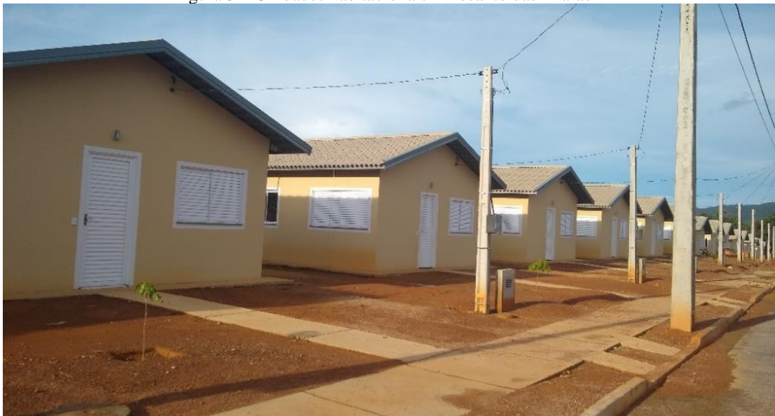
Figura 5 – Unidades habitacionais – Recanto das Araras 1
